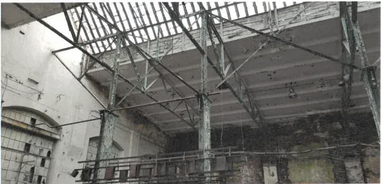
Budynek H1 - widok dachu od wewnątrz
