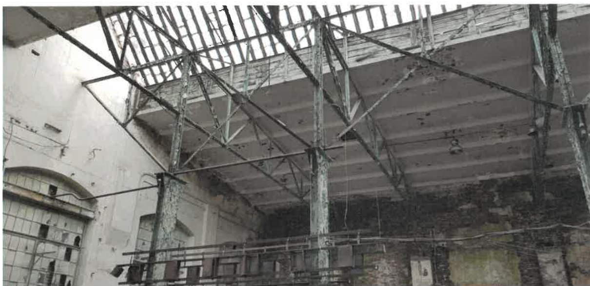
Budynek H1 - widok dachu od wewnątrz
