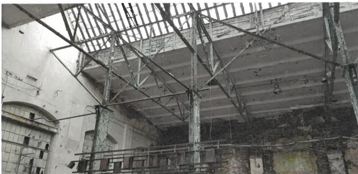
Budynek H1 - widok dachu od wewnątrz
